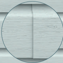
Jonction par recouvrement des lames
