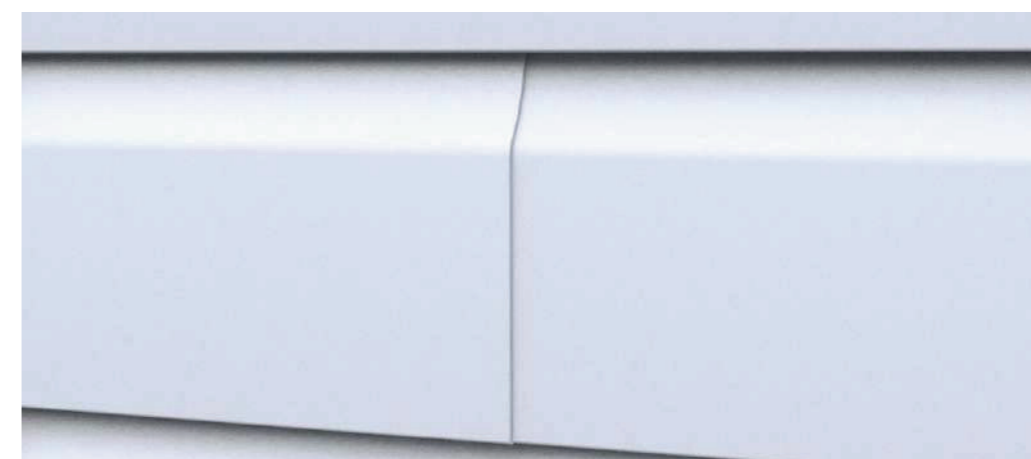
Jonction par recouvrement des lames
